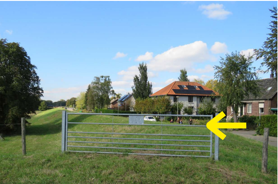
De gele pijl bij het hek geeft de nieuwe hoogte aan van de dijk
